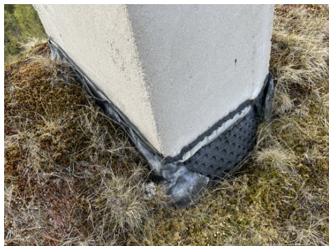
Bilde viser tetting rundt pipe.
